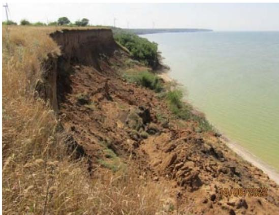
*Рисунок 1. Активный оползневой очаг на северо-западной окраине с. Порт-Катон Азовского района. Ряд сошедших блоков в теле оползня (фото Южного отделения филиала ЮРЦ ГМСН ФГБУ «Гидроспецгеология»)*
