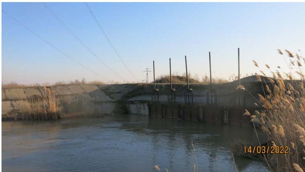
Фото 3. Водопропускное сооружение между западным и восточным отсеками
