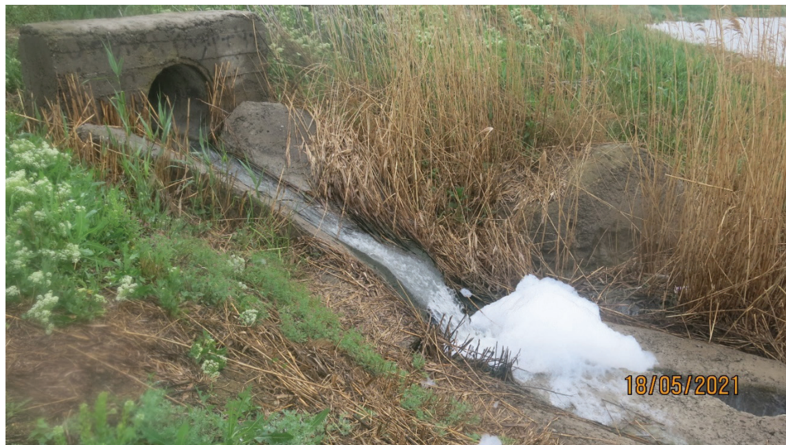
Фото 28. Сброс сточных (ливневых) вод (VK-1) в Цимлянское водохранилище на водовыпуске № 1 в г. Волгодонске Ростовской области
