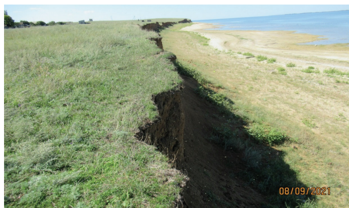
Фото 3. Обрушение коренного берега между х. Веселым и ст. Нагавской Котельниковского района Волгоградской области
