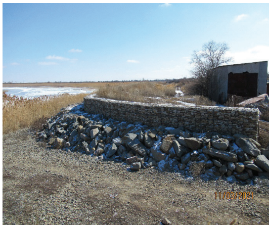
Фото 23, 24. Берегоукрепление Цимлянского водохранилища у х. Ляпичева и п. Донского Калачевского района Волгоградской области
