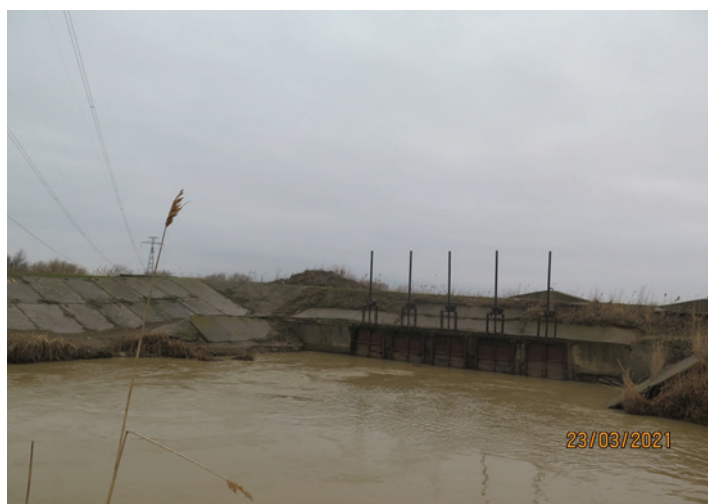
Фото 1. Водопропускное сооружение между западным и восточным отсеками.
