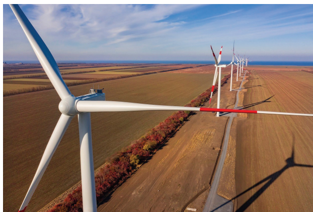
«Азовская ВЭС» мощностью 90,09 МВт, Азовский район. Введена в эксплуатацию в 2021 году
