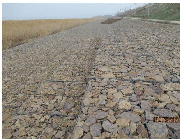
Фото 16. Берегоукрепление Цимлянского водохранилища в районе х. Логовский Калачевского района ВО
