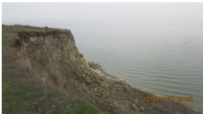
Фото 7. Обрушение коренного берега в границах ст. Хорошевской Цимлянского района Ростовской области
