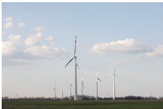
«Марченковская ВЭС» мощностью 120 МВт, Зимовниковский район. Введена в эксплуатацию в 2021 году
