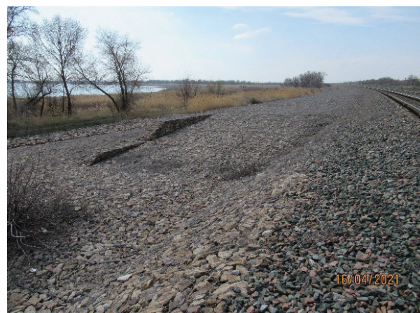
Фото 17. Берегоукрепление Цимлянского водохранилища в районе х. Рычковского Суrowsикинского района ВО
